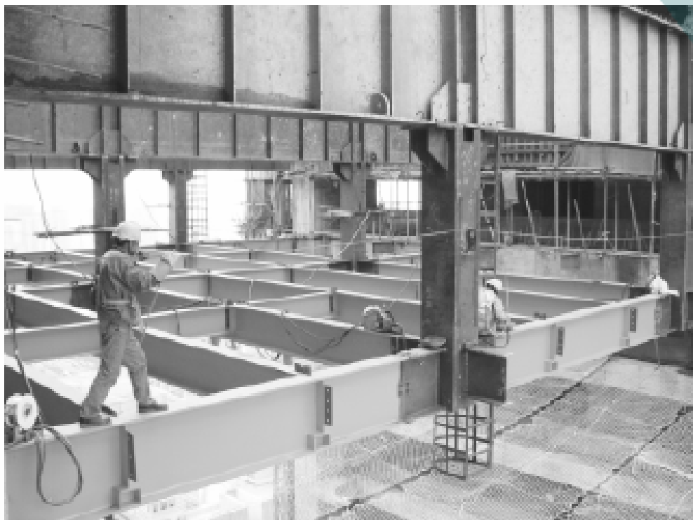
图 5 钢主梁下的悬挂避难层钢结构
