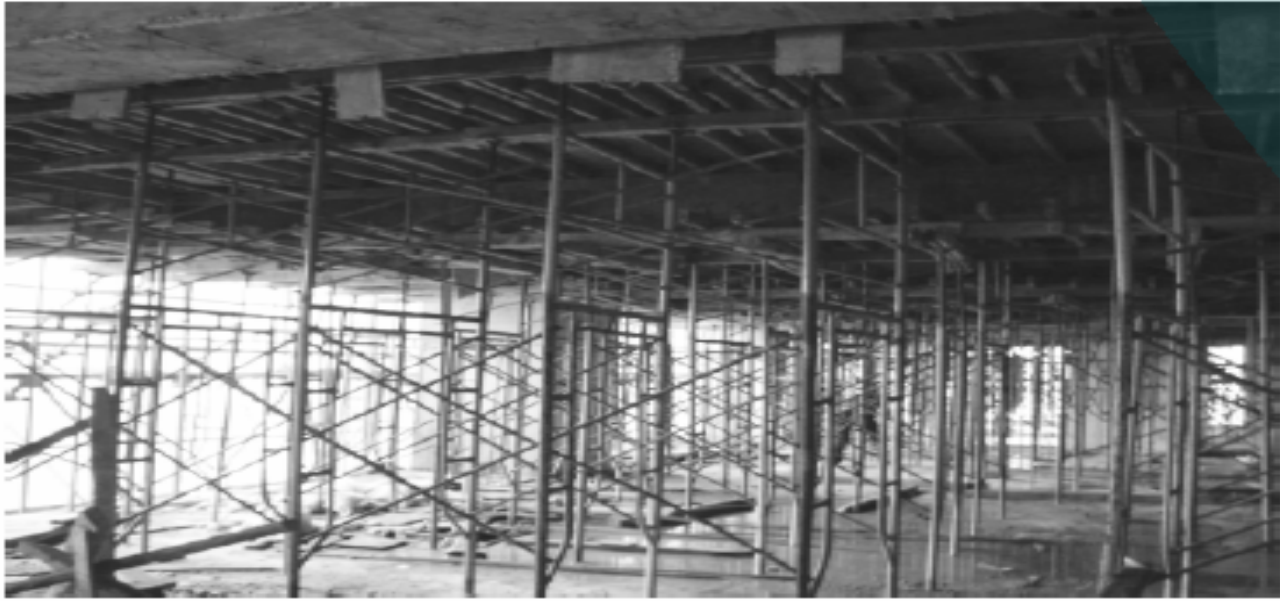
图 6 在避难层上搭设的支模架
