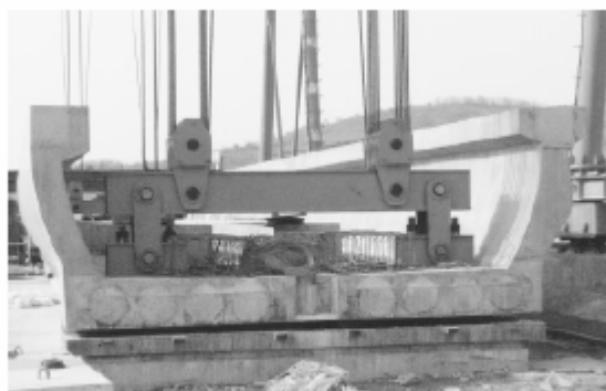
图 4 U 形梁的存放、吊装
