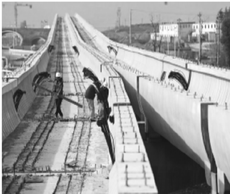
图 1 南京地铁架设的 U 形梁
